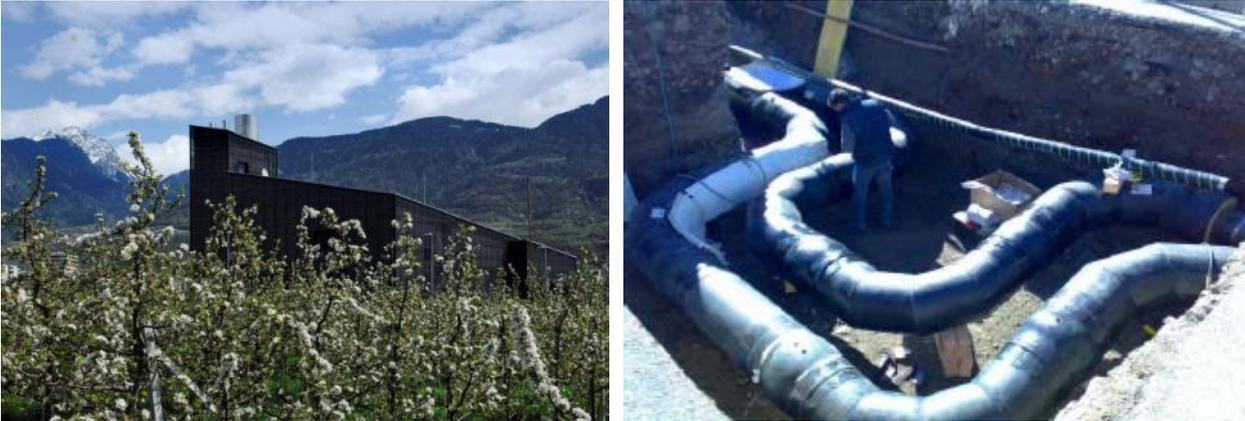
Abbildung 10: KWK-Anlage von Untermais und Fernwärmeleitung nach Sinich
