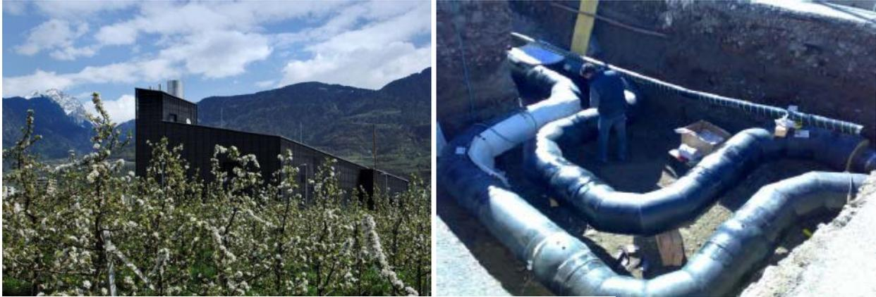
Figura 10: Impianto di cogenerazione di Maia Bassa e rete tele per Sinigo (sinistra)
